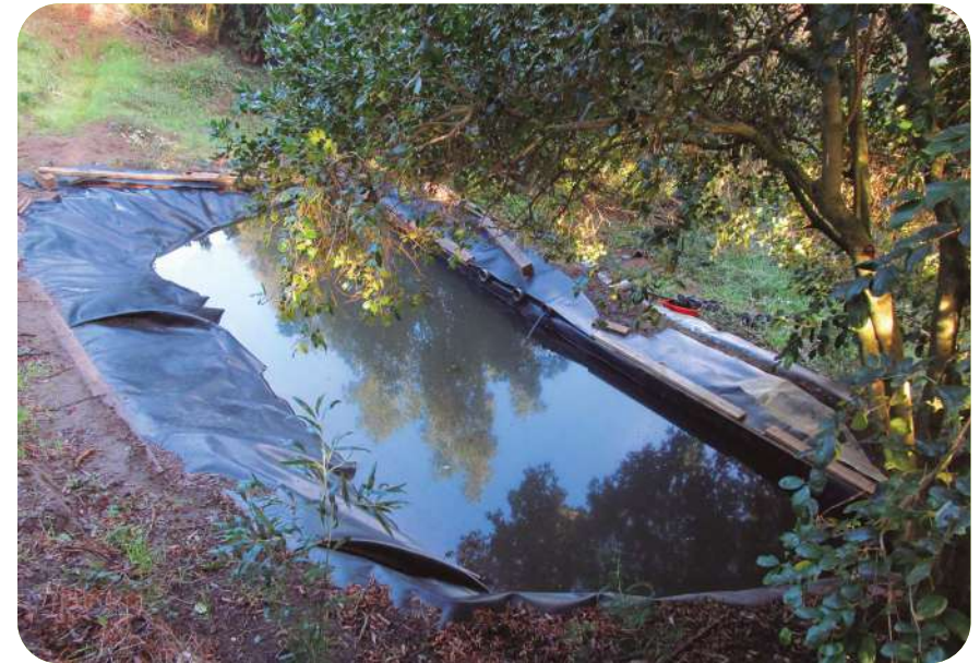
Sistema de cosecha de agua lluvia en minitranque
