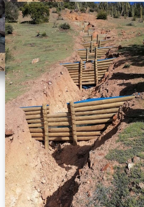
Muretes o diques
