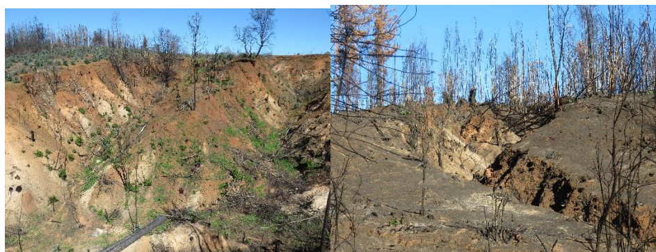
Figura 2.1. Cárcavas de gran tamaño presentes en los suelos afectados por incendios forestales 2017 en la zona Florida, Región del Bio Bio. Se originaron por el uso agrícola realizado en el siglo pasado. Foto E. Peña
